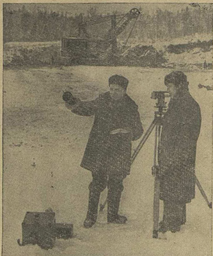
Идут вскрышные работы на главном добычном карьере на Гусевых горах. Маркшейдеры Н. П. Тукмачев и Ю. П. Бабкин (слева направо) разбивают на карьере трассу для горизонта 265.
