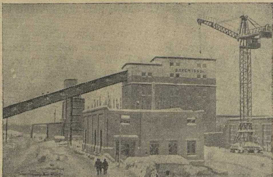
Крупный бетонно-растворный завод готов вступить в строй!
