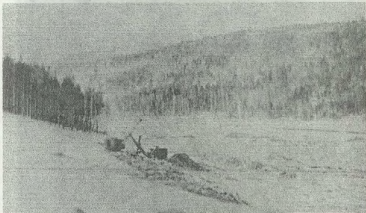
Начало строительства Выйской плотины
