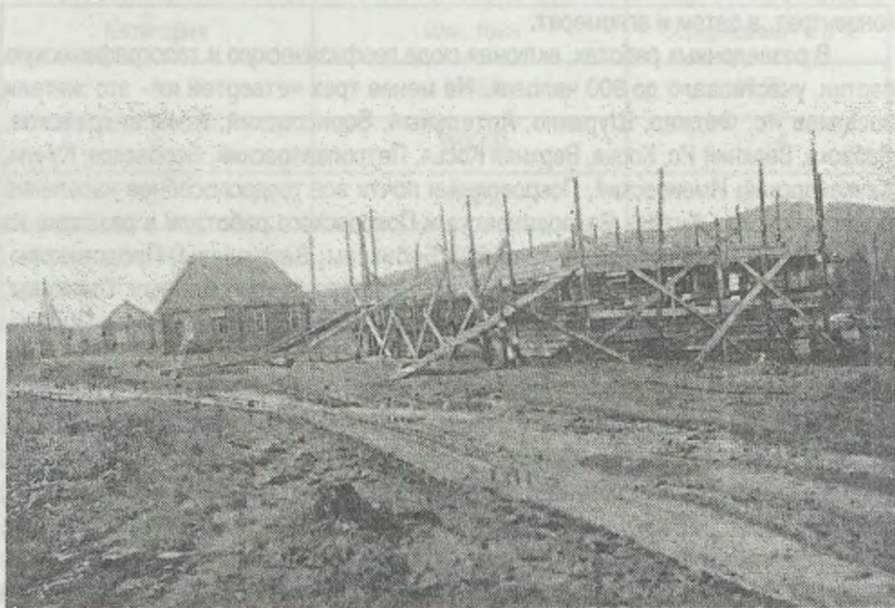
Строится здание конторы партии 1949 г.
