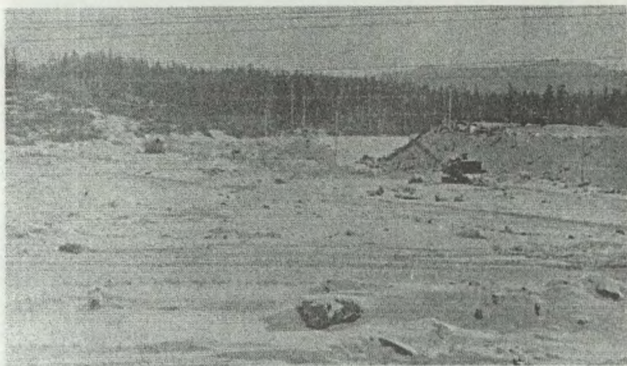
Отсыпка плотины шламохранилища
