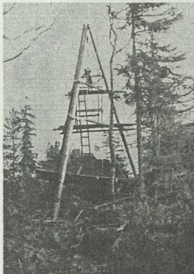
Буровая на вершине г. Качканар. Скважина № 404
