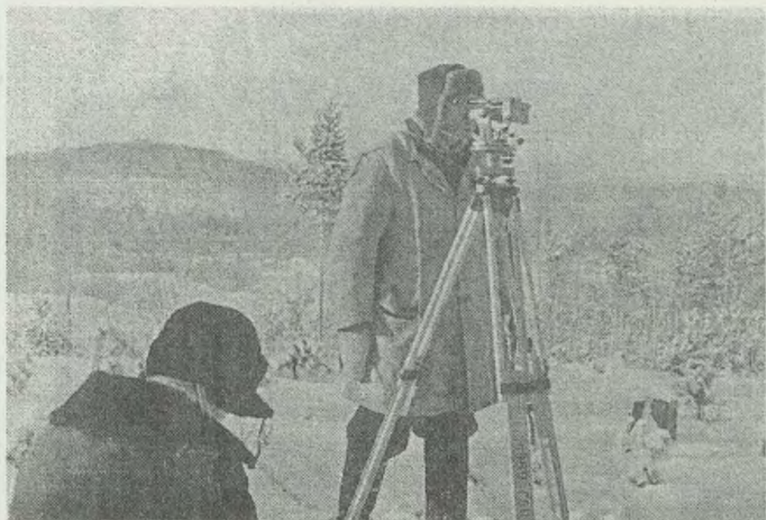
На съемке с дальномерной насадкой ДНБ маркшейдер В.В. Смирнов
