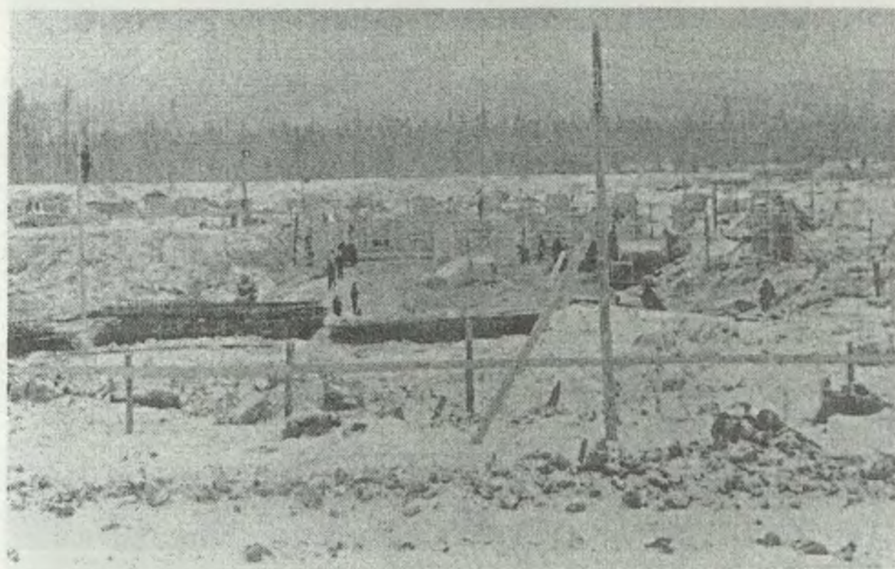
Закладка фундаментов на фабриках
